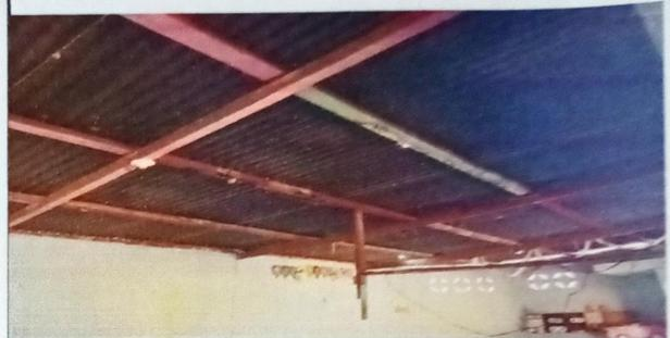
Foto 2: Sustitución de lámina, por lamina troquelada aluzinc calibre 26
