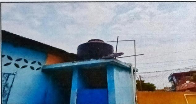
Foto 5: Sustitución de deposito de agua 1,000 lt
